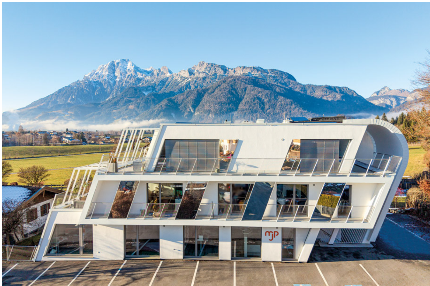
Die komplexen Schlosserarbeiten inklusive Geländer und Überdachungen tätigte die Arnsteiner Schlosserei.
