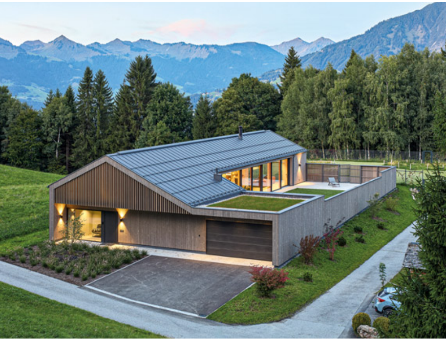
Noch schöner Wohnen geht kaum: Tolle Arbeit leistete das Team der Firma Martin Holzbau GmbH bei der Ausführung des Objektes.
