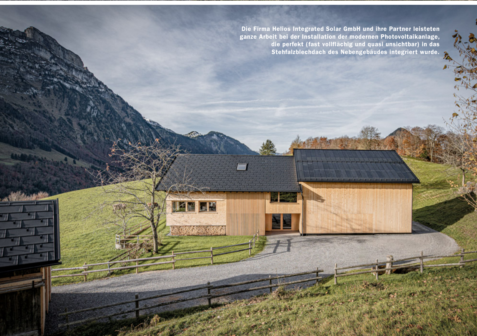
Das vorbildlich revitalisierte Wohngebäude wird von einem eleganten 'PREFA R.16 Dach' geschützt.
