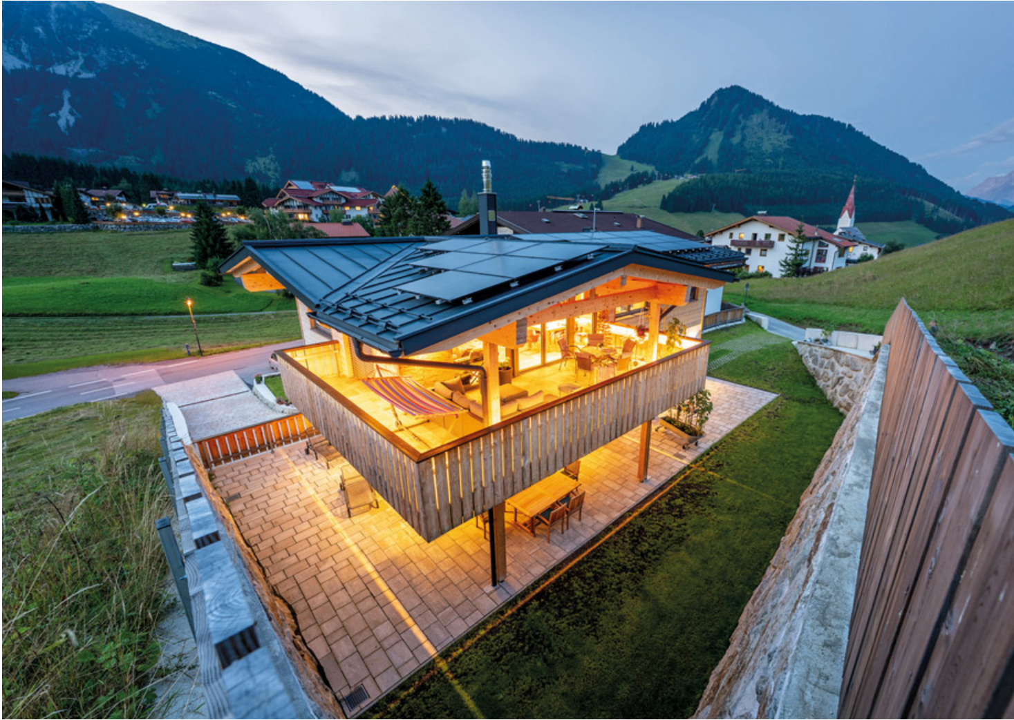
Das Chalet in Berwang nutzt Sonnenenergie in Form einer Photovoltaikanlage der Firma systech – solution GmbH.
