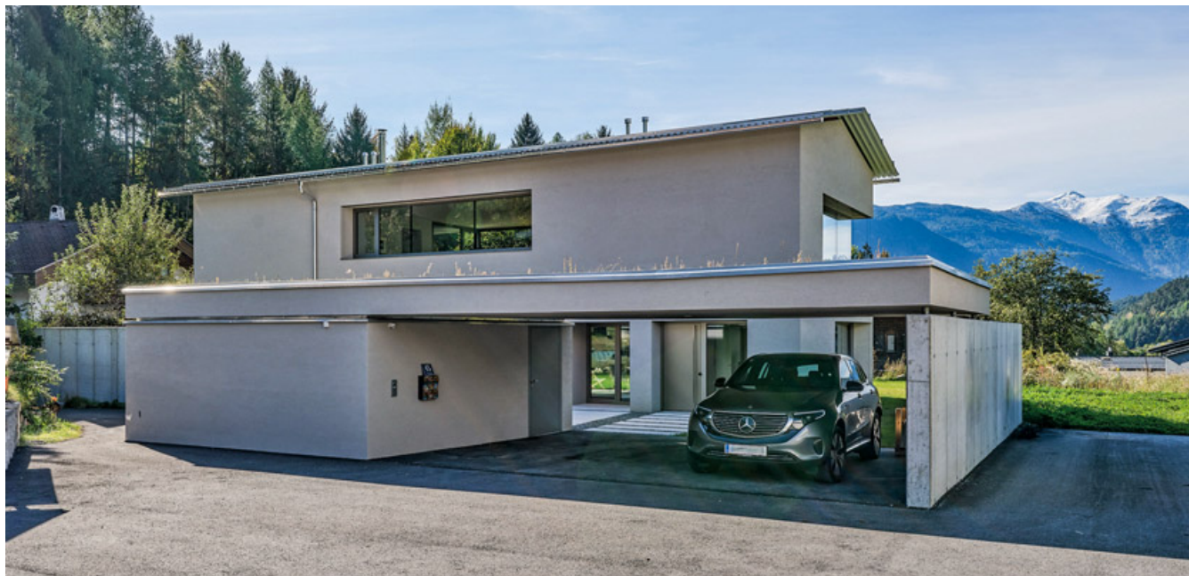
Alle Baumeisterarbeiten des massiv ausgeführten Einfamilienhauses führte die Firma Swietelsky AG aus.
