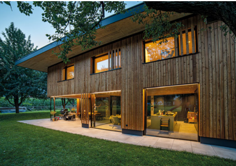
Die lässige Holzfassade wirkt modern und gleichzeitig traditionell.
