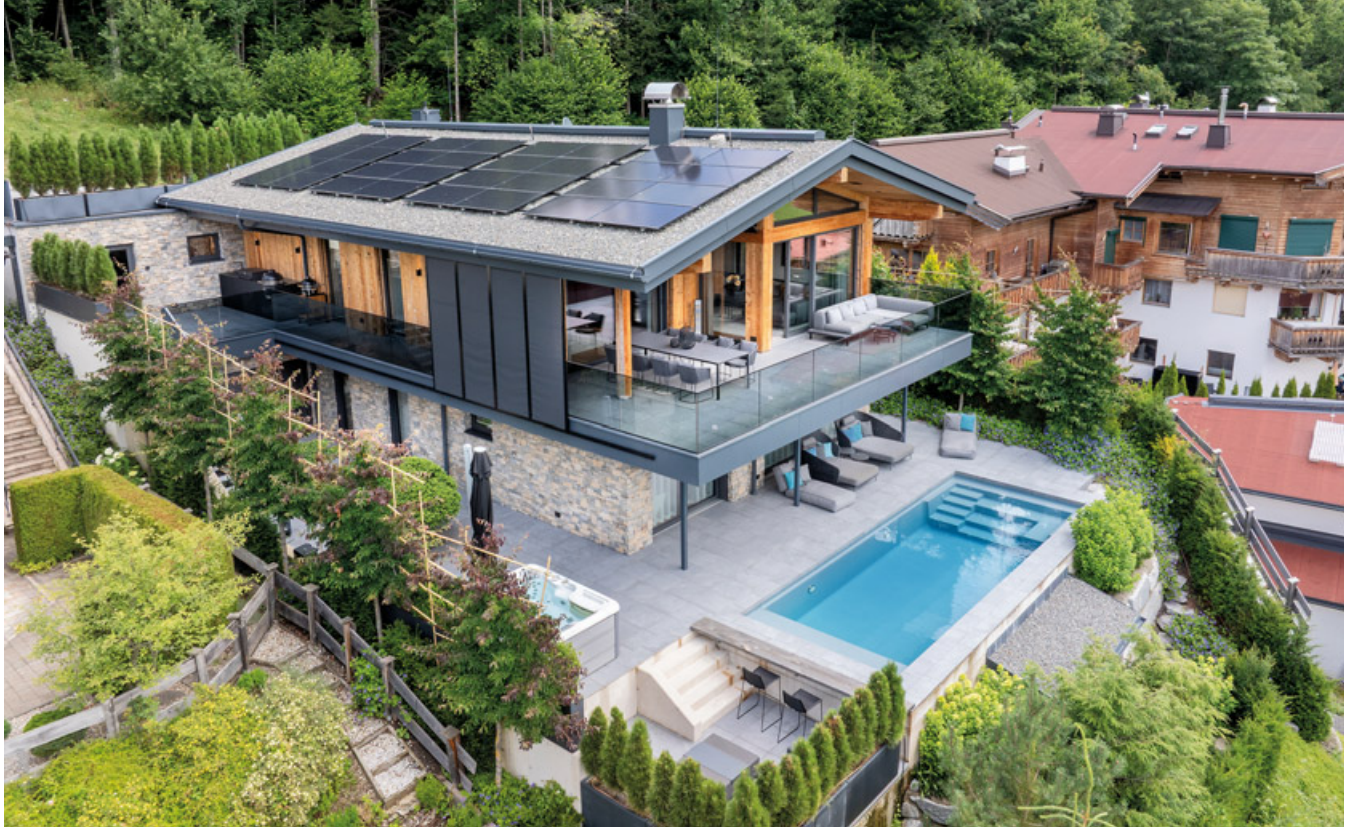
Sonnig & perfekt: Der stylische und vollautomatische Pool „Modena“ von RivieraPool wurde von der Firma bluspa - pool & relax gmbh gebaut und die Pflasterarbeiten führten die Experten der Firma Bruno Berger GesmbH aus.
