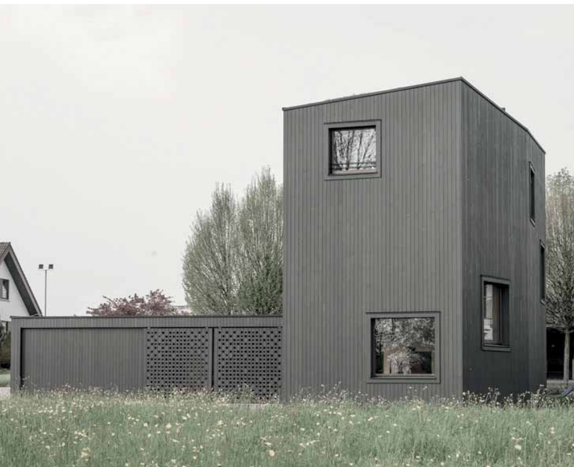
Außen dunkel lasierte Holzverkleidung und innen gebürstetes Weißtannentäfer – beides sorgfältig ausgeführt von der Firma Flatz Holzbau GmbH & Co KG.
