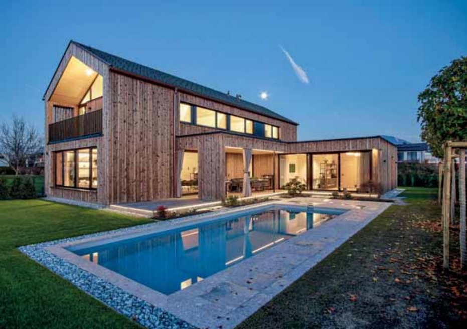
Attraktive Outdoor-Badeoase: Die ausgeklügelte Pooltechnik stammt von den Experten der Firma BWT GmbH.
