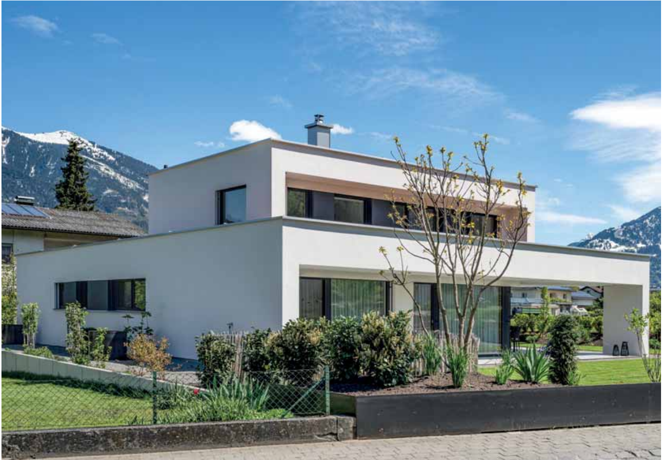
Die Flachdach- und Spenglerarbeiten setzten das Team der Spenglerei Mathis aus Altsch sorgfältig um.
