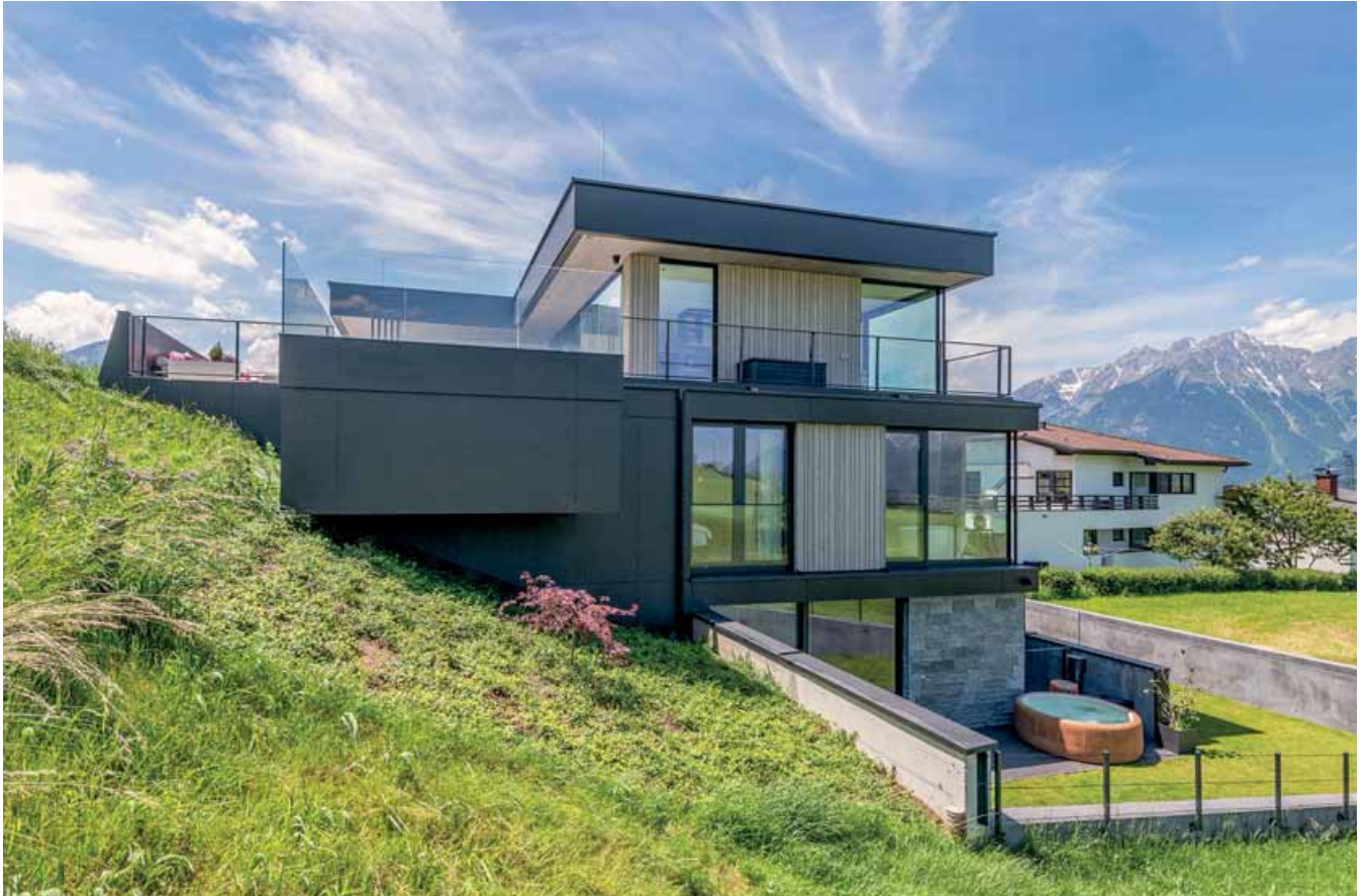
Die anspruchsvollen Baumeisterarbeiten für den modernen Baukörper führte die Firma HS-BAU Innsbruck aus.
