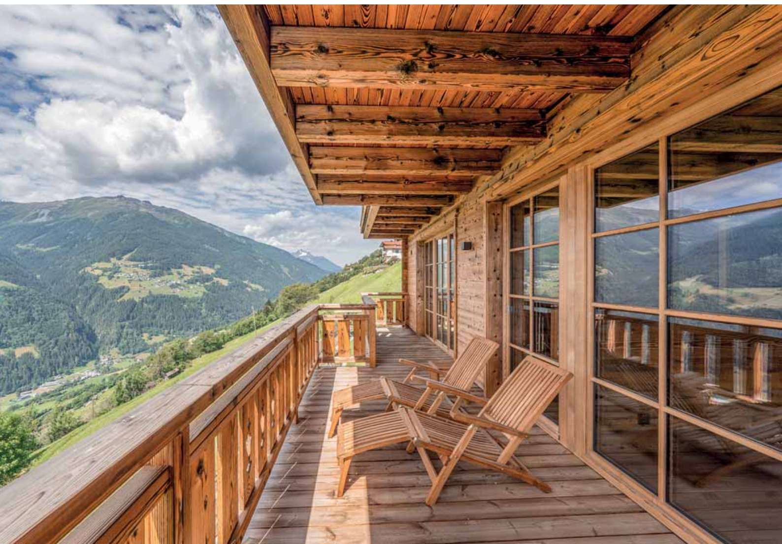
Das Prefa-Satteldach und sämtliche Spenglerarbeiten wurden von der Knabl Spenglerei ausgeführt.
