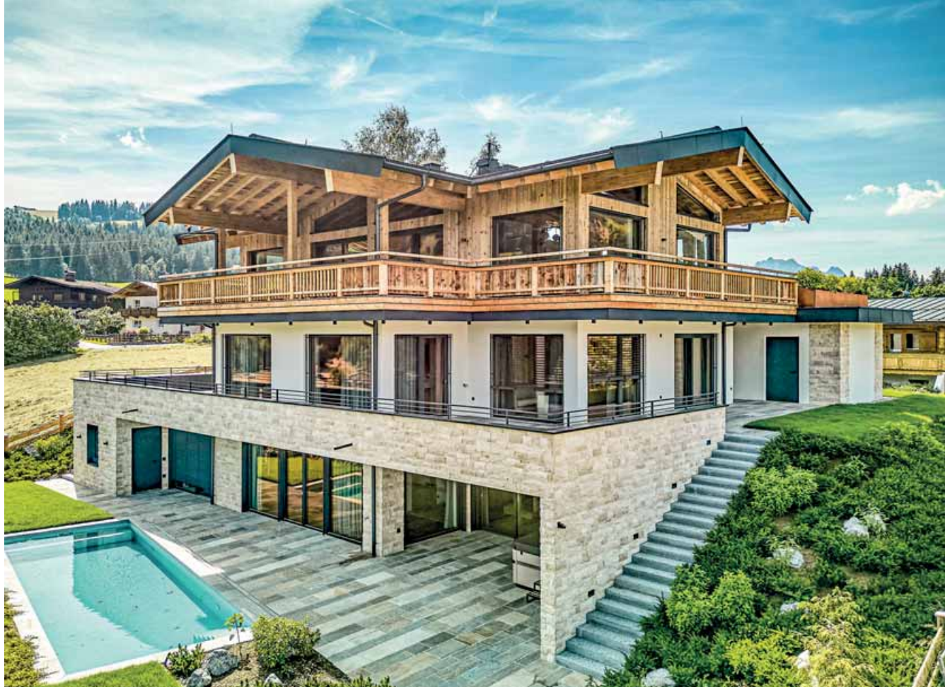
Die komplexen Dach- und Spenglerarbeiten des komfortablen Domizils führte die Firma Erich Siorpaes, die Pflasterarbeiten das Team der Firma Pflasterbau Kogler aus.
