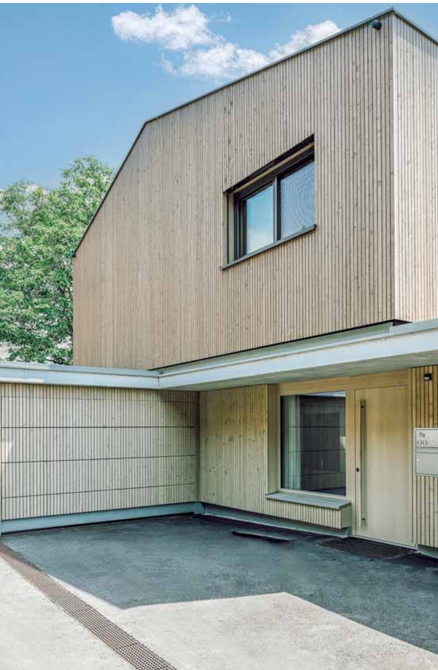
Die Dach- und Spenglerarbeiten für das markant-asymmetrische Satteldach führte das Team der Firma Spenglerhandwerk FeMA GmbH & Co. KG aus.
