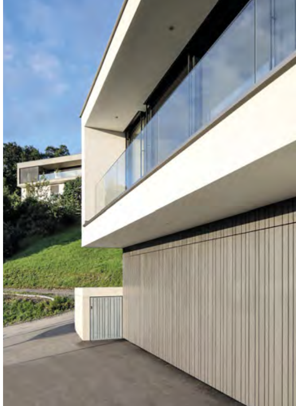
Die hochwertigen Baumeisterarbeiten führte die Firma Haller Bau GmbH aus.
