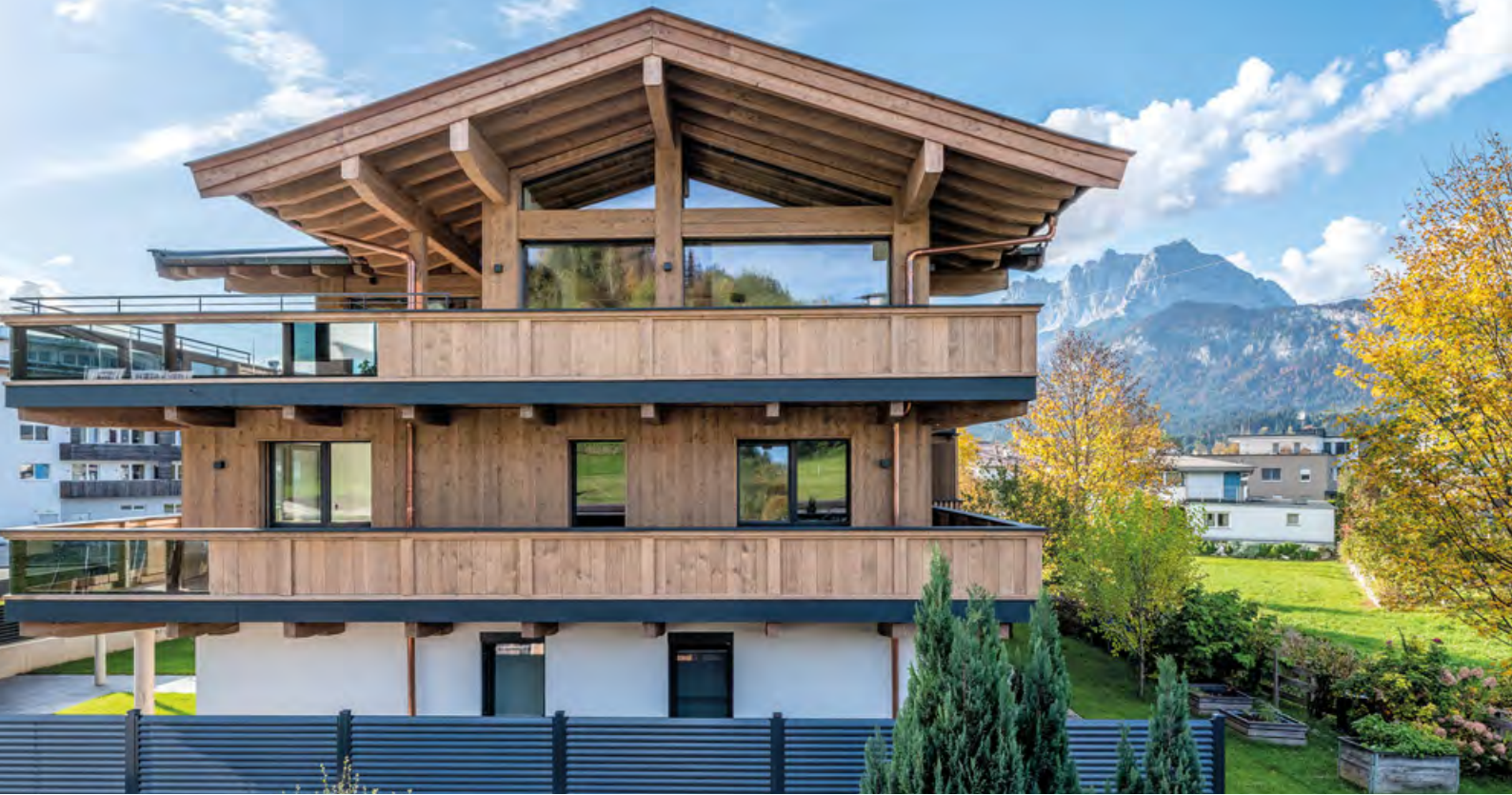
Für die beiden neuen Ebenen in Holzbauweise wurden moderne Fenster von Polin Baustoffe Kitzbühel verwendet.
