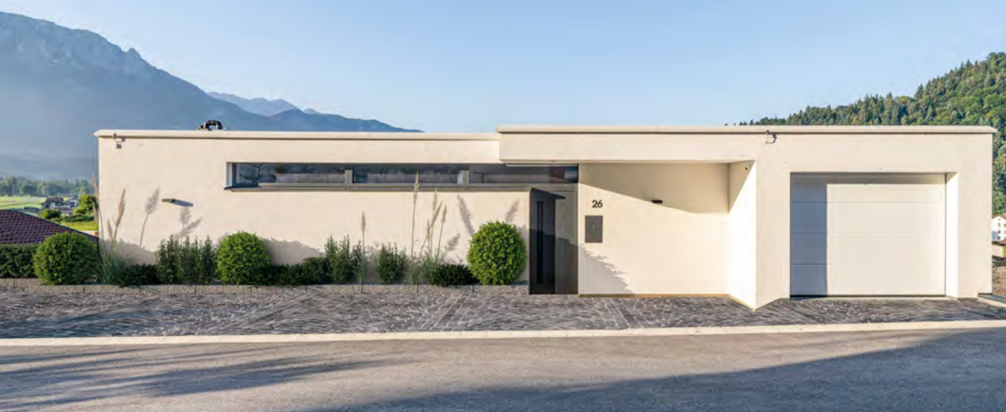
Höchste Qualität der Ausführung – Baumeisterarbeiten durch die Firma Hörfarter Bau-GES.M.B.H. – bildet die Basis des schönen Objektes.
