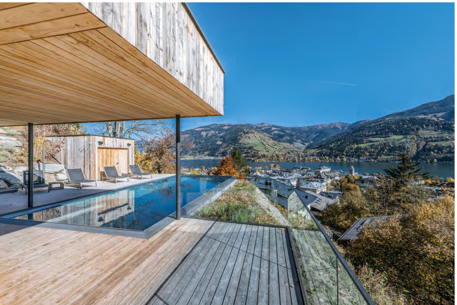
Den Seeblick gewährleistet auch die Glasbrüstung. Dach- und Spenglerarbeiten stammen von der Firma Breitfuss GmbH.
