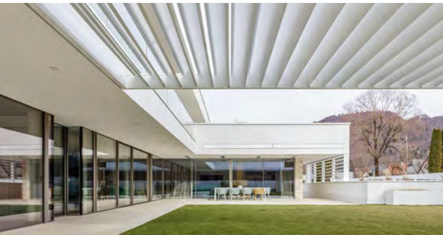
Die ökologische und recyclebare Fassade fertigte die Firma All-in-Protect GmbH aus Grossarl.
