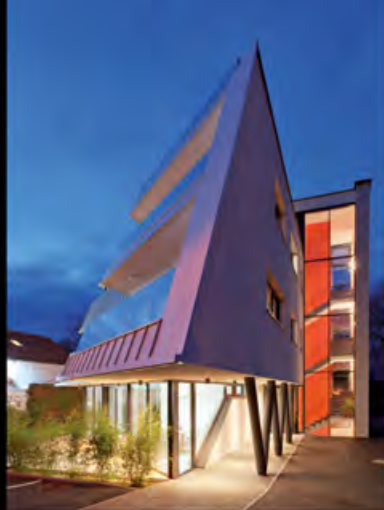
mehrfamilienhaus switil, bürmoos
