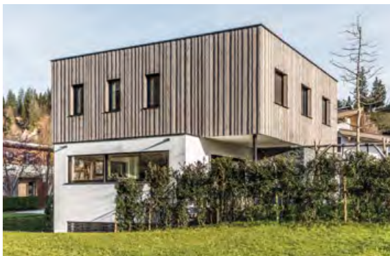
Ein Refugium, das heimische Bautradition in die Gegenwart überführt.
