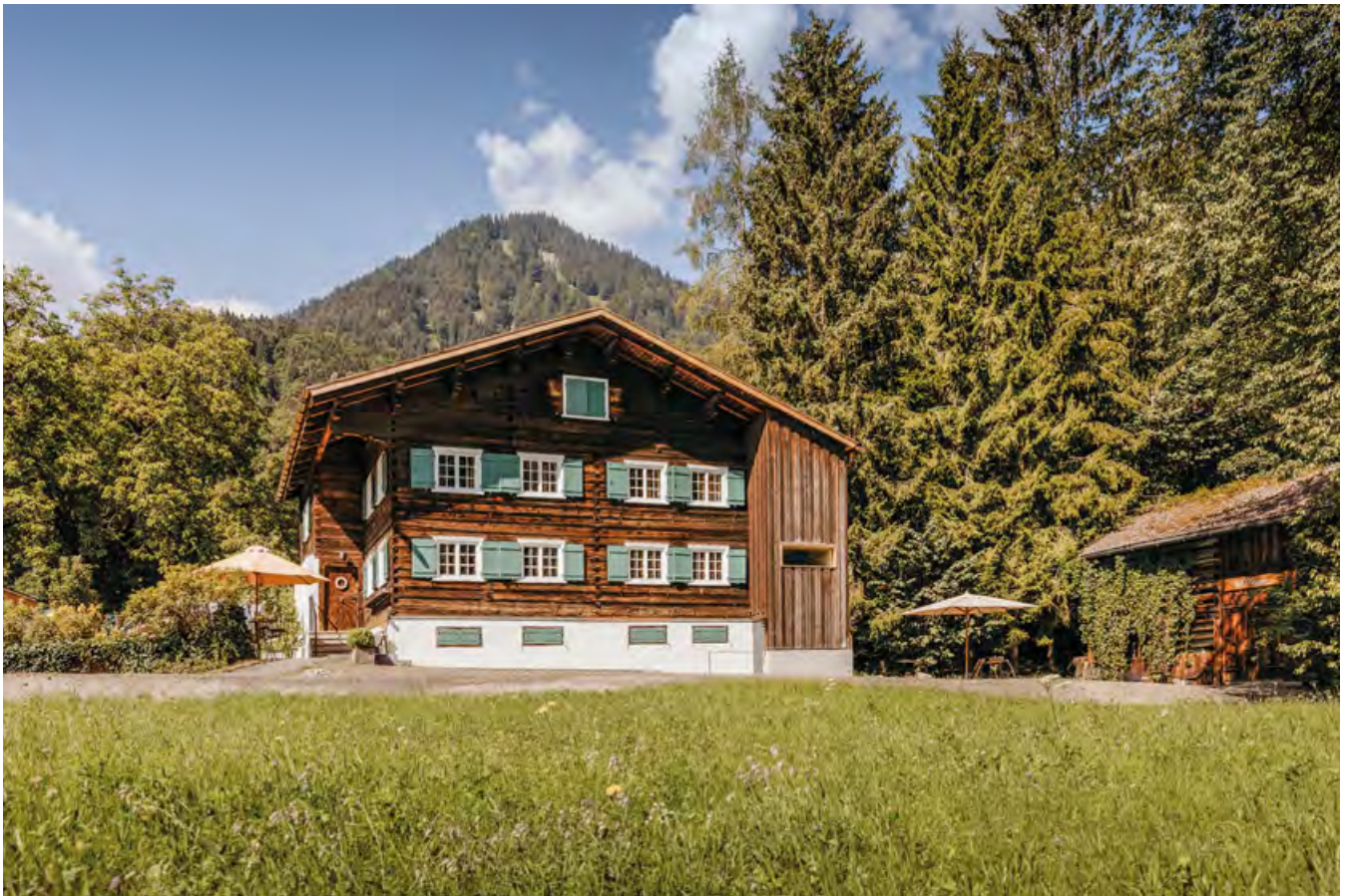
Das familiengeschichtlich einzigartige Walserhaus wurde zu neuem Leben erweckt.
