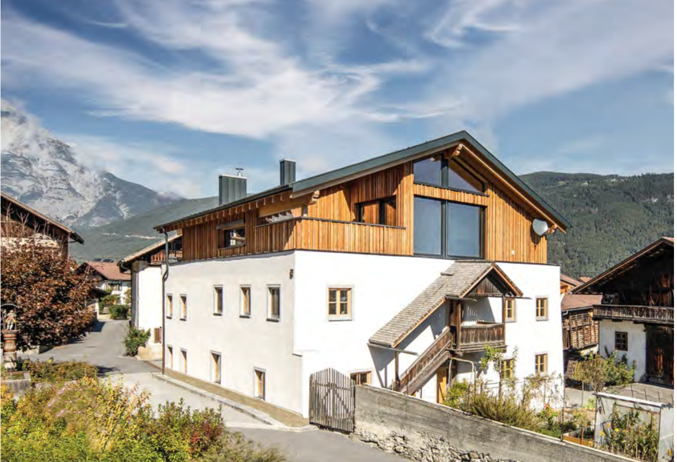
Der Stoanerhof ist ein Revitalisierungs-Vorzeigeprojekt. Alle Fenster, Türen und Innentüren im Bestand lieferte die Tischlerei Krismer.
