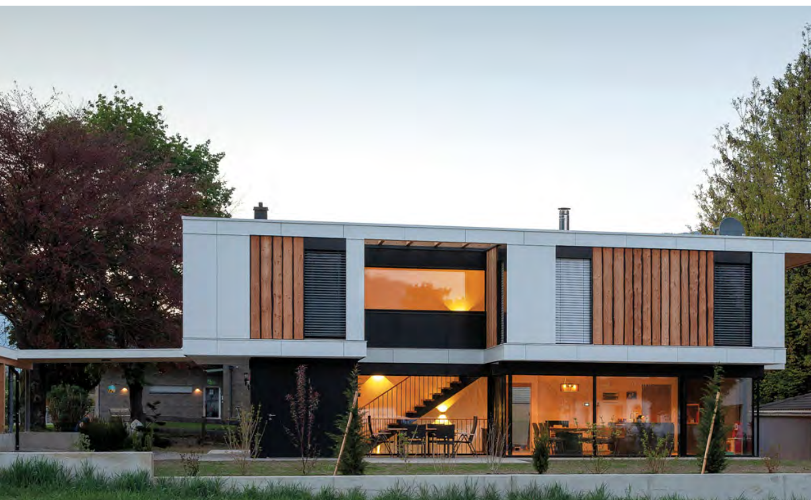
Für das Haus in Uderns führten die Fachleute der Firma Holzbau Kofler den Holzriegelbau aus.
