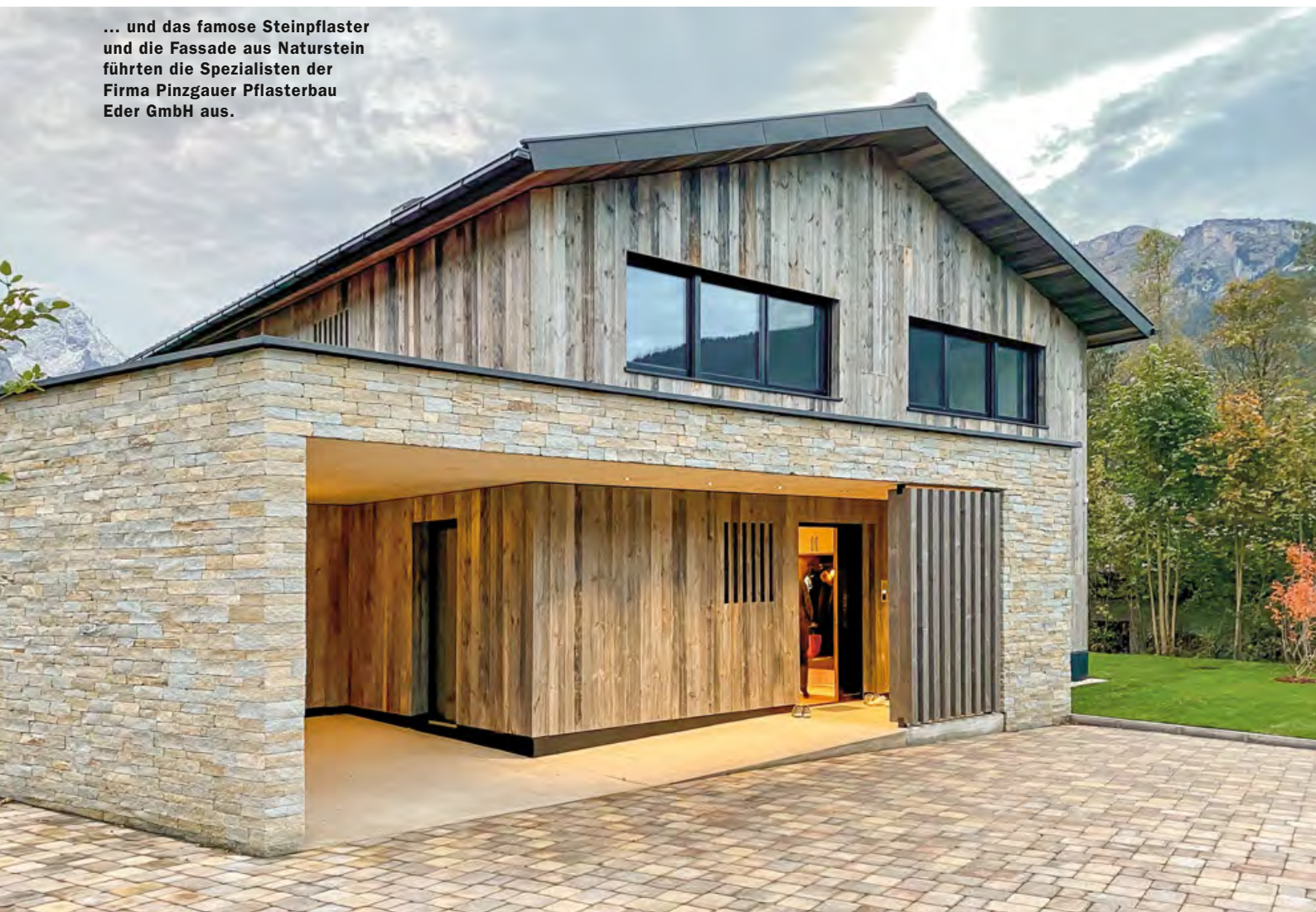
Urtyp in modern: Für die Baumeisterarbeiten wurde das Team der Firma Eitler Bau GmbH engagiert, die handwerklich perfekte Holzbauarbeit lieferte Meiberger Holzbau ...
