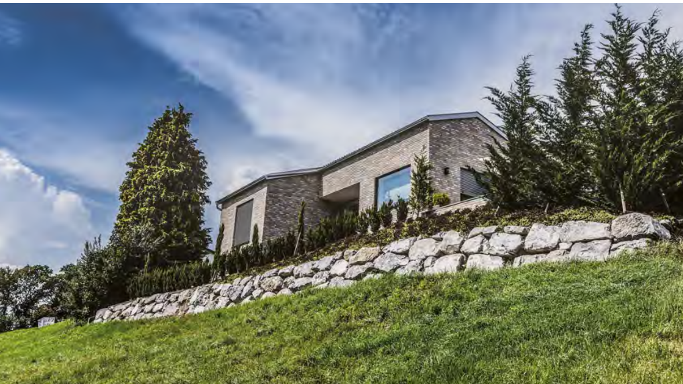
Die Renovierung und der Anbau harmonieren perfekt. Die Baumeisterarbeiten führte das Team der Firma BSG Bau GmbH aus.
