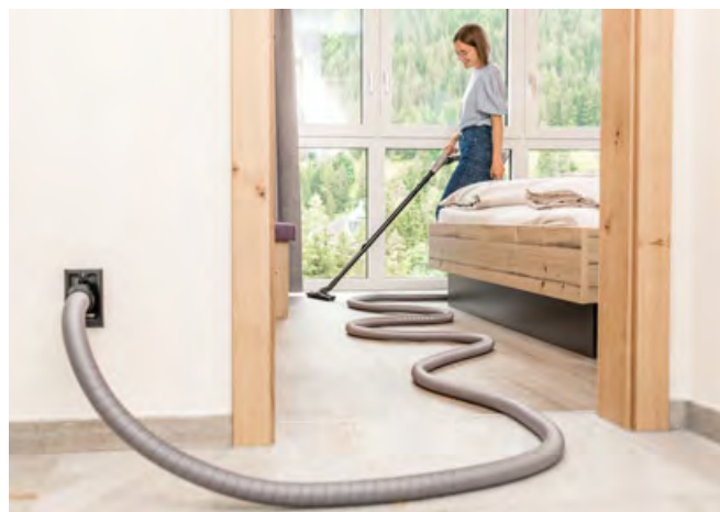
Dank des leichten, langen und flexiblen Saugschlauchs reicht meist eine Anschlussdose pro Stockwerk.
