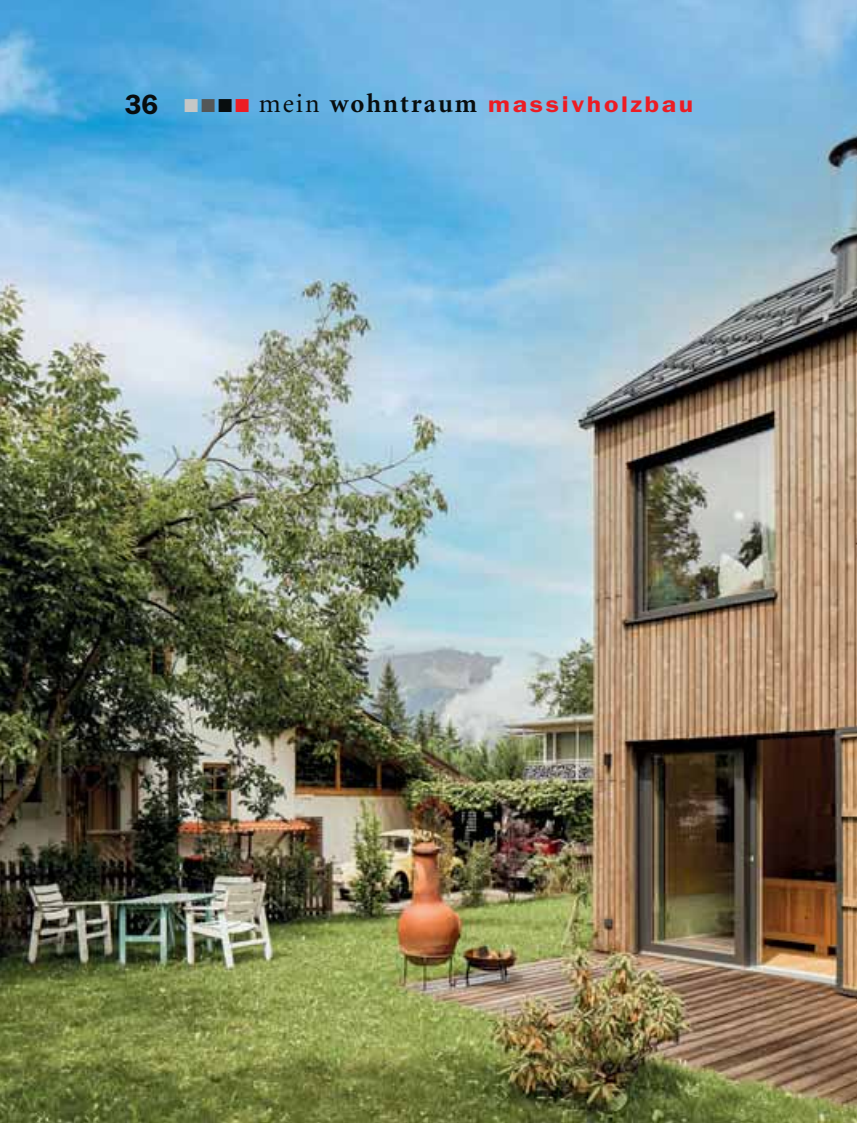
Eine markante vertikale Fichten-Lattung prägt die Außenansicht. Für den Holzbau war das Team der Firma Holzbau 32.50 OG verantwortlich.
