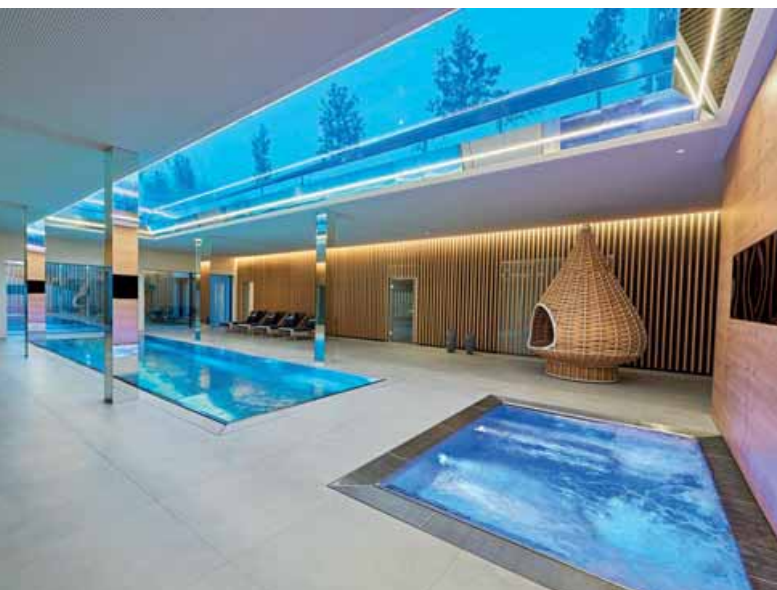
Unter dem Glasboden des Outdoor-Pools befindet sich ein exklusiv ausgestattetes Hallenbad mit Whirlpool und Überlaufbecken aus Edelstahl.
