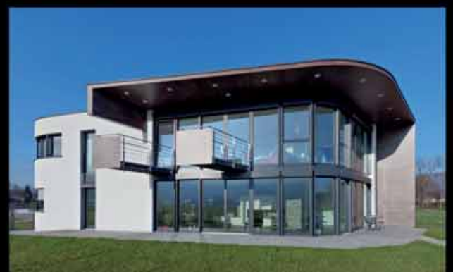
haus k, hallein
