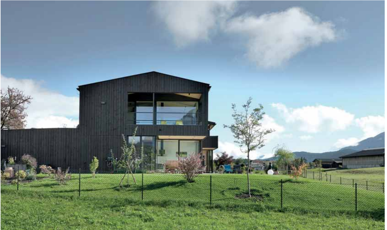
Moderne Architektur und Ausführung durch das Team der Holzbau Firma DACH+FACH Holzbau GmbH treffen bei diesem Objekt optimal zusammen.
