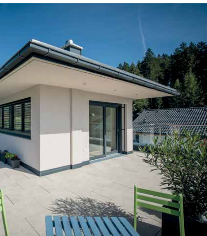
Überblick auf der Dachterrasse.
