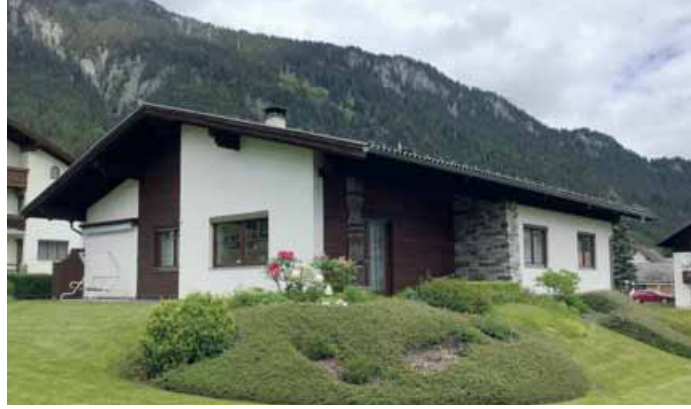
VORHER Ein Bungalow aus vergangenen Jahrzehnten war die Ausgangsbasis für den Umbau und die Aufstockung in Holz.
