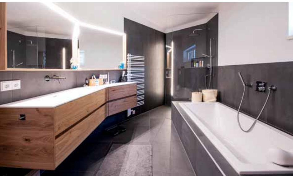
Effekt durch punktgenaue Beleuchtung und Elektroinstallationen der Firma Elektro Volderauer.
