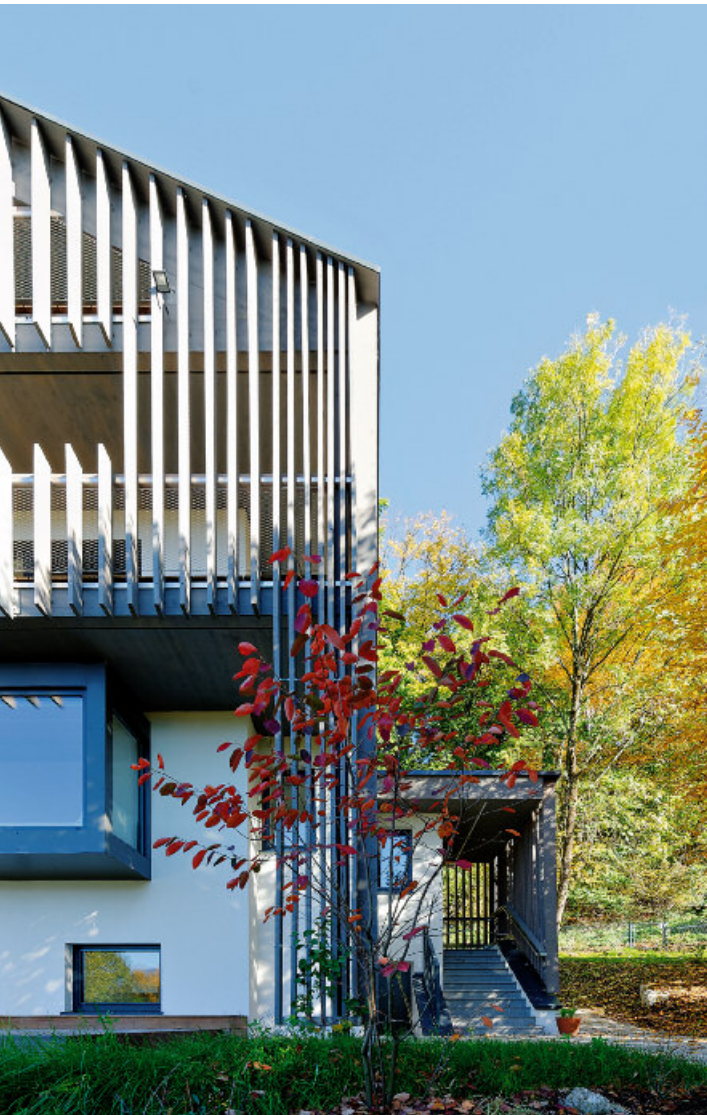
Außen überzeugt die neue Fassade mit Lärchenlattung, innen tut dies die individuelle Maß-Möblierung der Tischlerei Grömmner.
