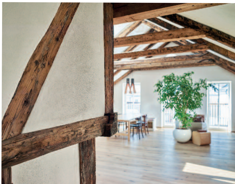
Optimale Verglasungen lassen viel Tageslicht in das denkmalgeschützte Gemäuer.
